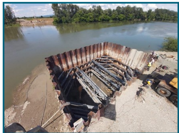
Iskop i razupore zagata temelja stuba S3
