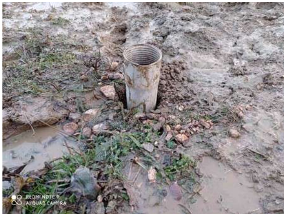
Slika 3. Ugradnja cijevu pijezometra u bušotinu
