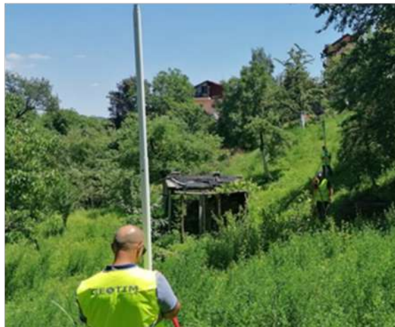
Slika 5. Geodetsko opažanje kontrolnih tačaka
